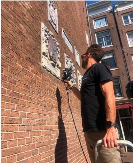
Zomer: Sebastiaan Kuiper scant de gevelsteen in de Luciensteeg. Met dat bestand zijn door Albert Kramer kopieën gemaakt van drie gevelstenen in savonnières die in Oudewater geplaatst gaan worden. De gevelstenen zijn gepolychromeerd met keim kalkverf in terughoudende kleuren.
